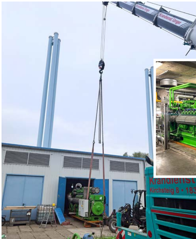
Präzisionsarbeit: Das neue Blockheizkraftwerk wird mit einem Kran in die Halle gehoben.
